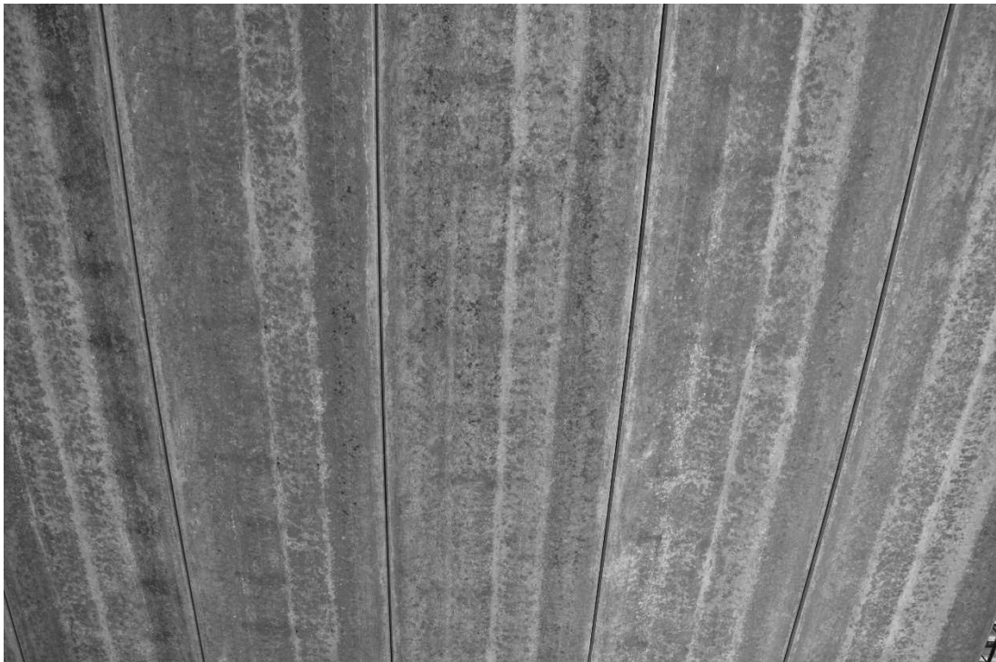
Fot.1.1 Typowy obraz przebarwień na dolnych powierzchniach płyt
